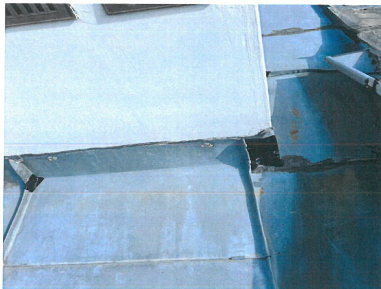
Fot.8. Widok naprawianej obróbki blacharskiej komina (taśmą dekarską)
