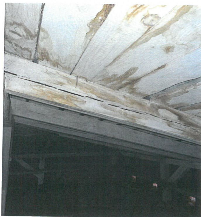
Fot.13. Widok deskowania i krokwi zacieki na całej powierzchni.
