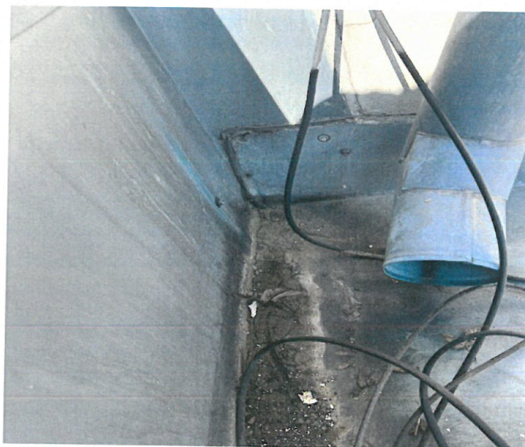
Fot.12. Widok zastoiska wody opadowej. (kable grzewcze bez mocowań)
