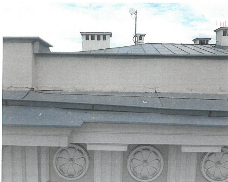
Fot.7. Widok obróbki blacharskiej gzymsu wieńczącego (zarysowania ściany kolankowej)
