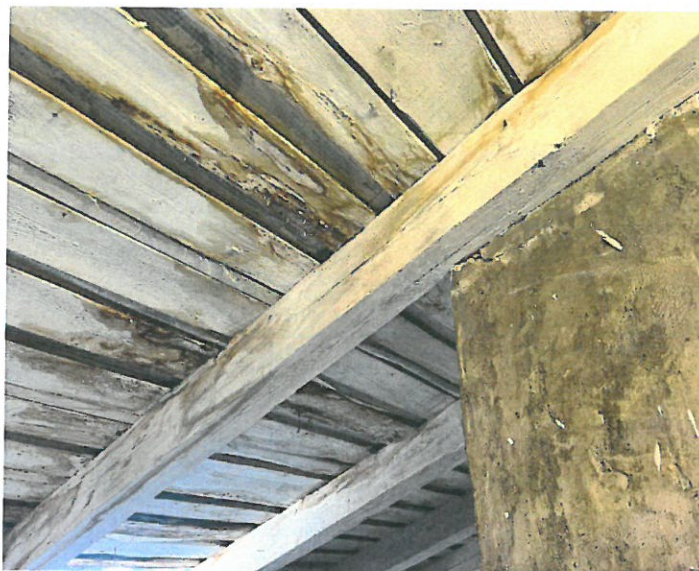
Fot.16. Widok deskowania - zacieki przy kominie.
