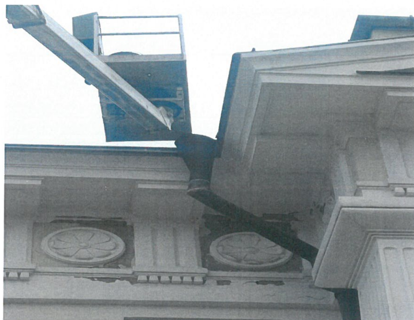
Fot.3. Widok narożnika od zewnątrz (skutki penetracji wody, niszczenie rozet, kroksztyn, fryz)
