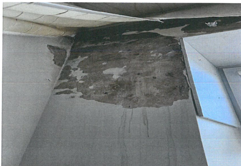
Fot.4. Widok narożnika od wewnątrz (skutki penetracji wody w pomieszczeniu sekretariatu)
