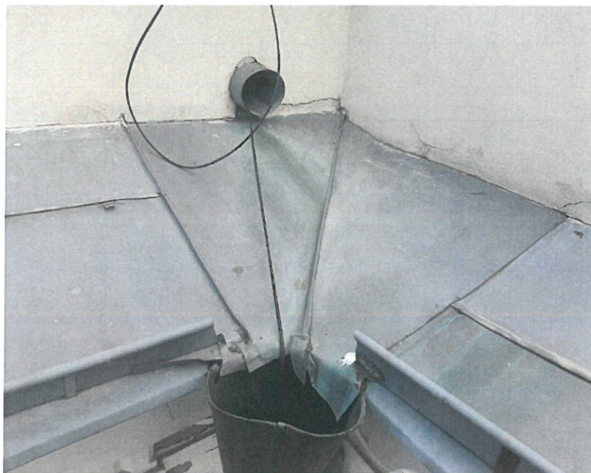
Fot.5. Widok obróbki blacharskiej do rury spustowej (przy ścianie attykowej)
