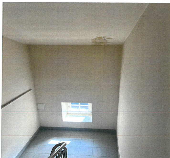
Fot.19. Widok klatka schodowa - przeciek na suficie
