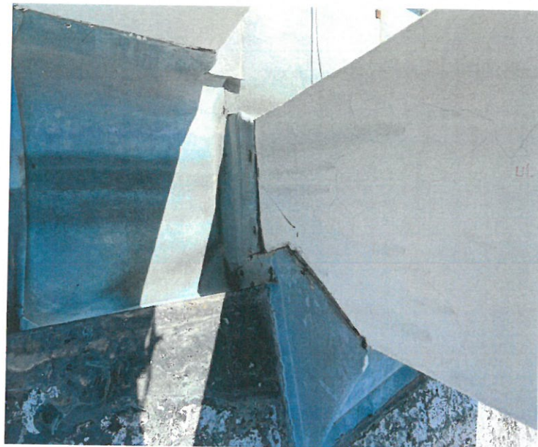
Fot.11. Widok obróbki komina, korodującej blachy , zarysowania na powierzchni ściany komina.
