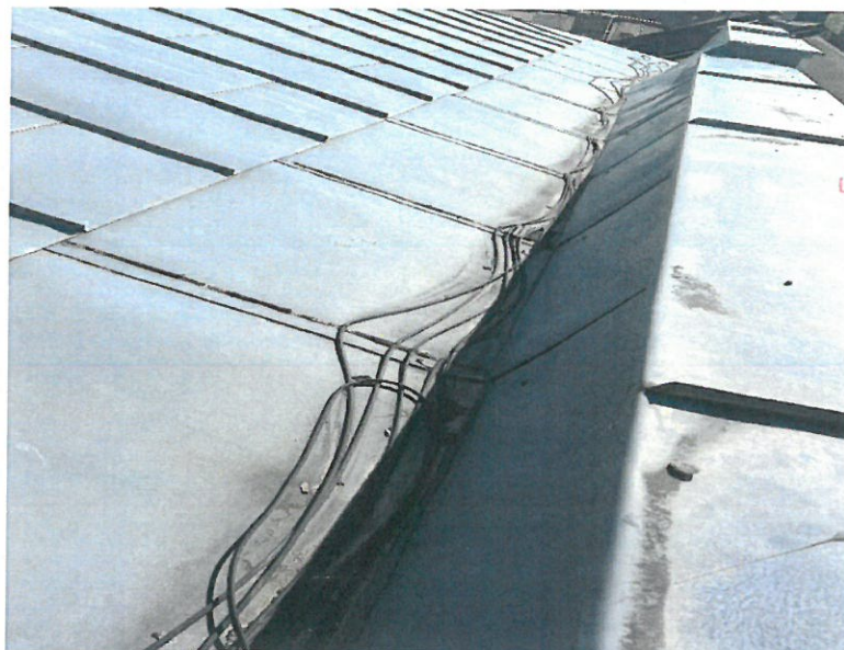
Fot.9. Widok nie działającego kabla grzewczego.
